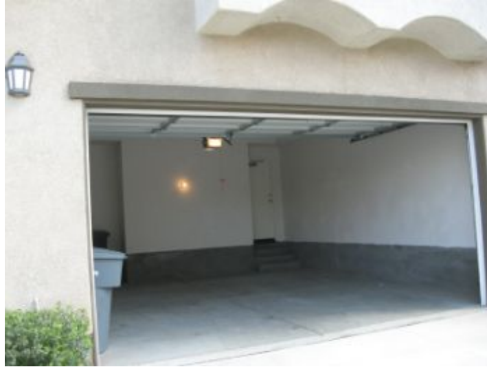
Garage Exterior Door
